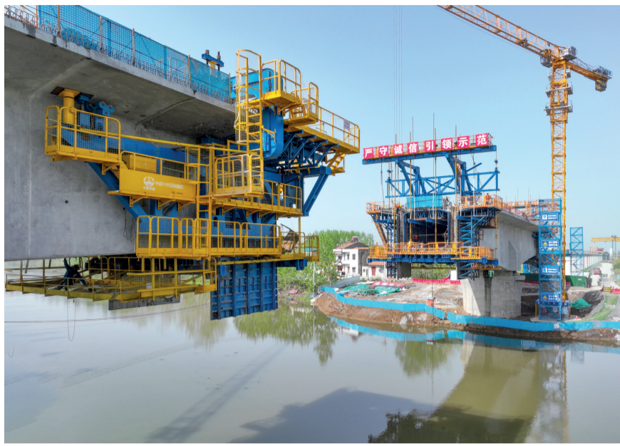
孝天特大桥跨民乐渠连续梁施工
