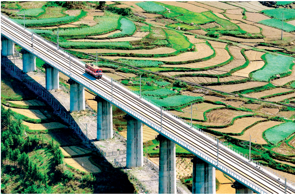
添乘车驶过梯田衬托下的银坡河双线特大桥
