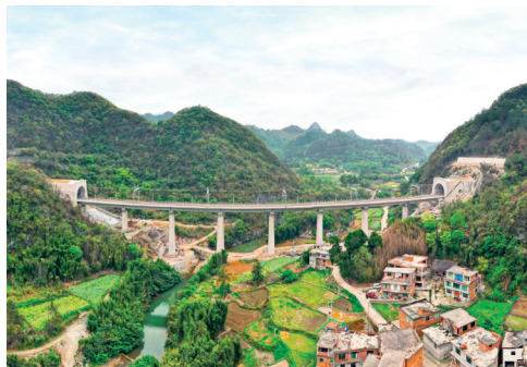
桥隧相连的漂洞河2号双线大桥
