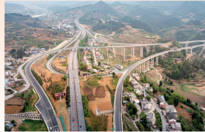
五公司承建的仁(怀)遵(义)高速公路苍龙互通枢纽。
