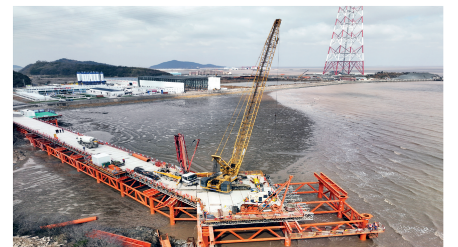
二公司承建的甬(宁波)舟(山)高速铁路西堠门公铁两用大桥栈桥搭设。
