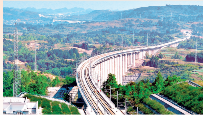
二公司承建的贵(阳)南(宁)高速铁路银坡河特大桥。
