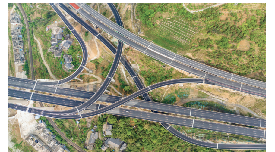
四公司承建的重(庆)遵(义)高速公路松坎互通枢纽。
