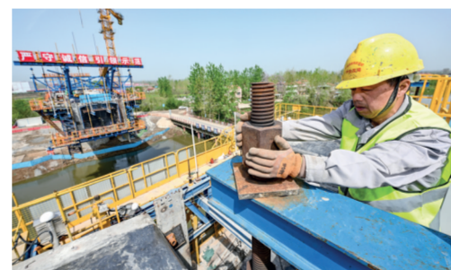
一公司沪(上海)渝(重庆)蓉(成都)高速铁路武宜段2标一分部作业人员安装智慧造桥机挂篮承重支架螺母。
