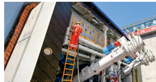
上海公司承建的桐乡乌镇大道顶管施工。
