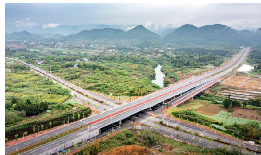
钢结构建筑公司承建的贵州新蒲经济开发区新田东路洛安江大桥。
