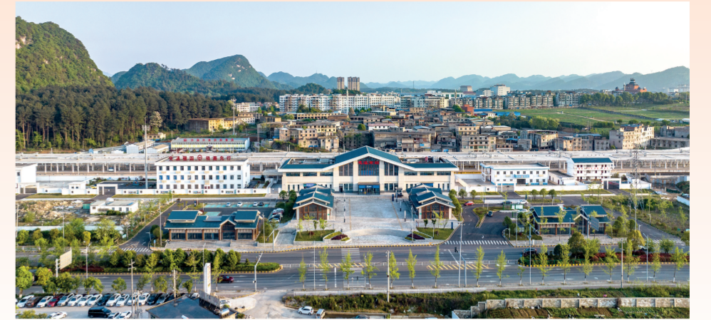
一公司承建的贵阳铁路枢纽花溪南站。
