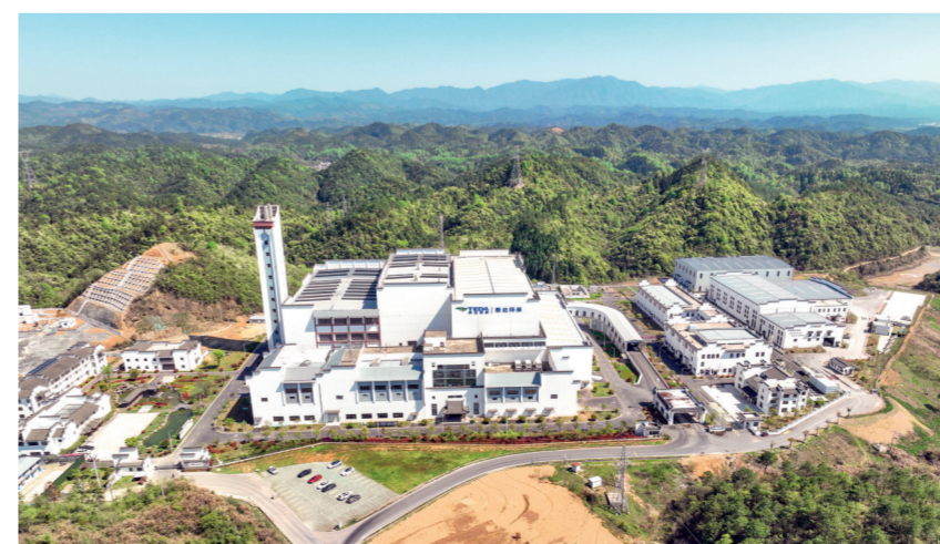
三公司承建的黄山市生活垃圾综合处理厂工程。
