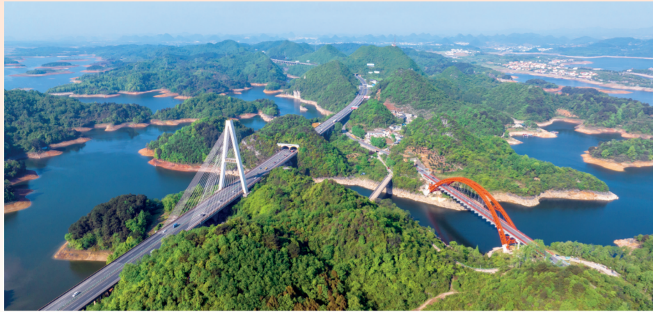
二公司参建的清(镇)镇(宁)高速公路。
