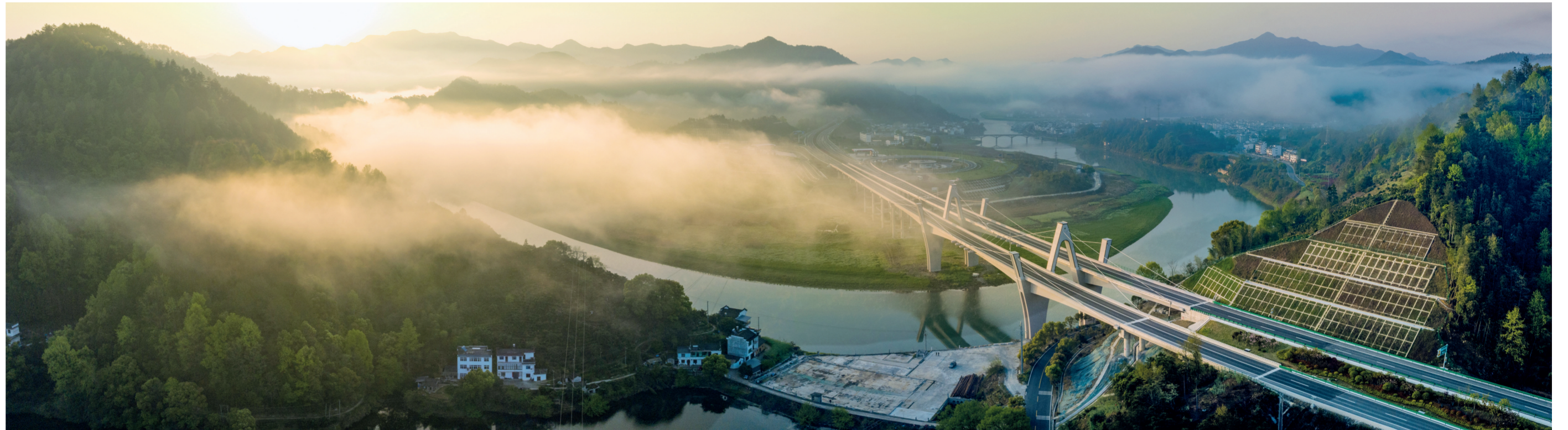
四公司承建的黄(山)千(岛湖)高速公路昌源河大桥。
