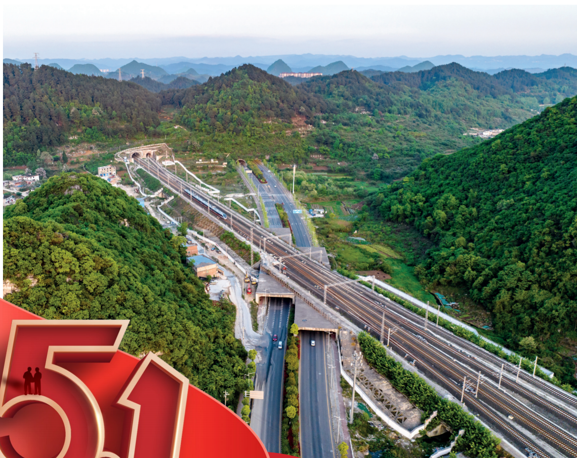
一公司参建的贵阳市域快速铁路西南环线通车运营。
