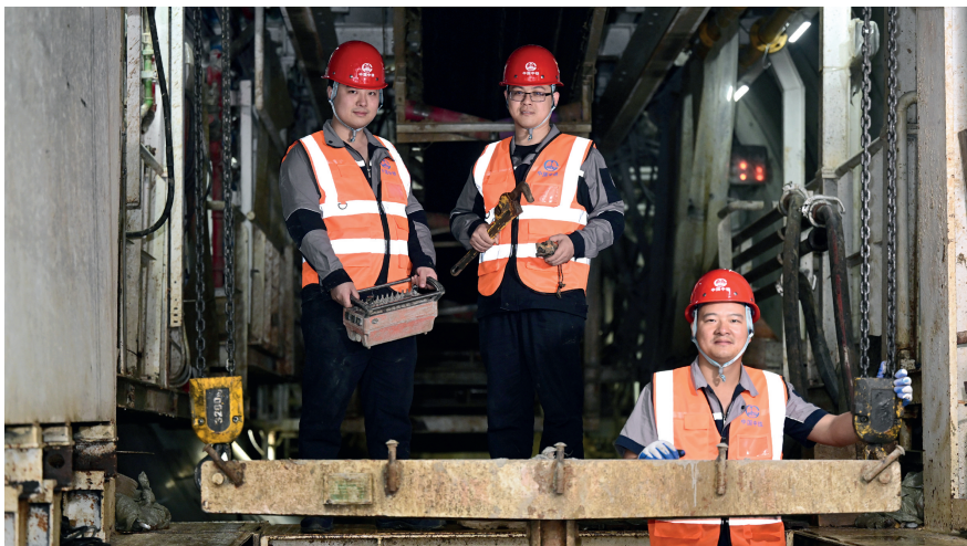
合肥轨道交通7号线盾构施工现场 从左往右:汪润 魏传荣 谢能
