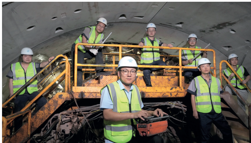
广佛环线广州南~大石站区间盾构施工现场 从前往后,从左往右:田广积、边振华、王永刚、宗扬扬、田洲、王秀北、陈崇
