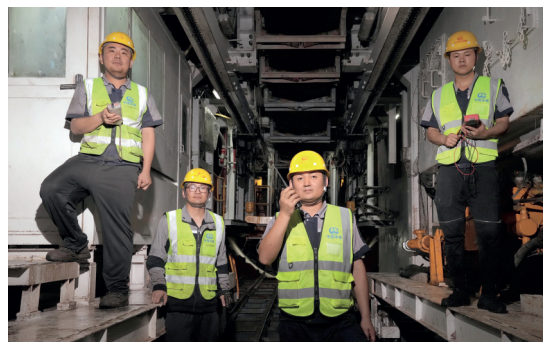
佛山地铁4号线盾构施工现场 从左往右:赵永州、王志鹏、姜建中、周国樑
