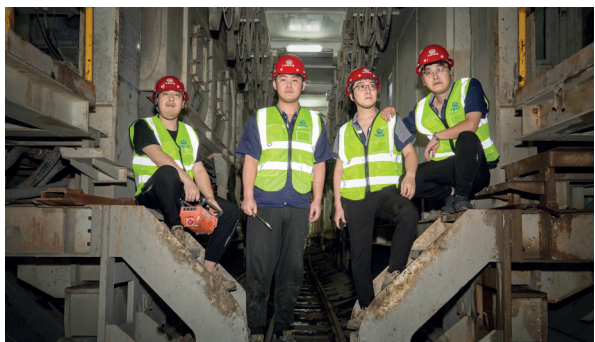
福州滨海快线盖山站-三盖左线站区间盾构施工现场 从左往右:樊旺、王永杰、白帆、陈亮
