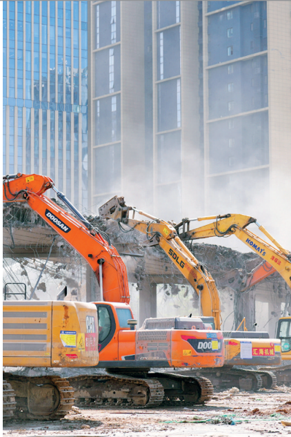
桥梁梁板破碎拆除
