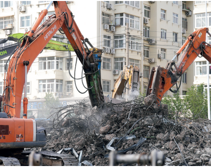
破碎锤分解梁板
