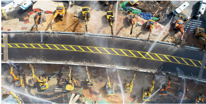
洒水车不间断洒水助力环保施工
