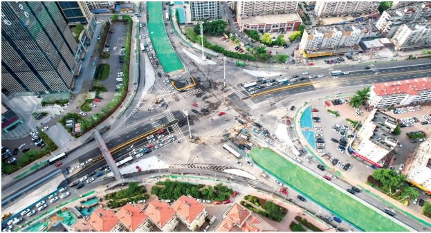
拆除完成后,地面交通全面恢复
