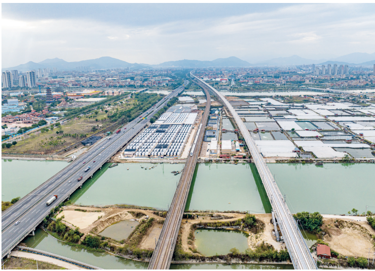
5月20日,中铁四局参建的福(建)厦(门)高速铁路开始联调联试。
