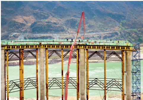
匝道三联连续梁施工
