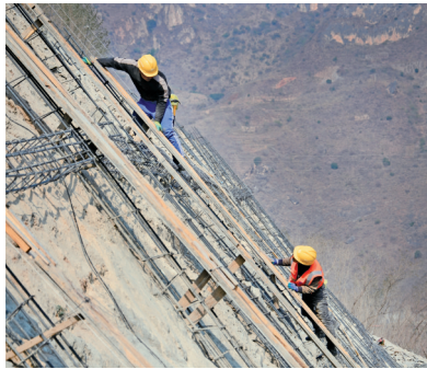
高边坡立模板
