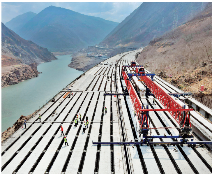
主线主架方向T梁架设完成
