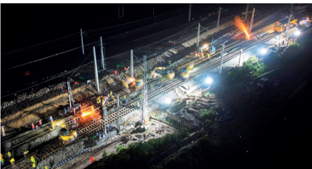
施工现场航拍
