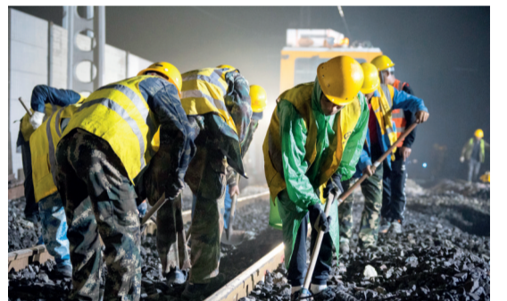
施工人员清理铁轨石砟
