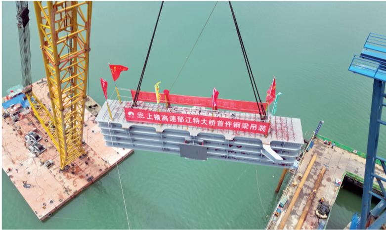
5月25日，中铁四局五公司、钢结构建筑公司参建的上(林)横(州)高速公路西津郁江特大桥梁首个钢梁吊装。西津郁江特大桥梁是长1190米，主桥长680米，主跨400米，设计为双塔双索面钢混组合梁斜拉桥。上横高速公路建成后，对推动沿线旅游业快速发展、全面推进乡村振兴具有重要作用。
