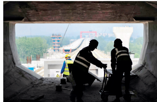
现场工人正在箱梁内安装配重块
