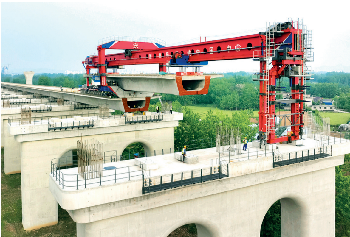
千吨架桥机正在架梁作业
