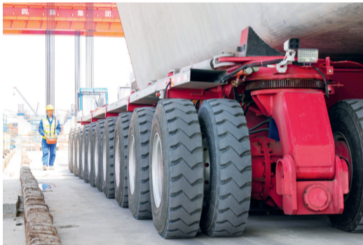
现场工人正在操纵运梁车运送箱梁
