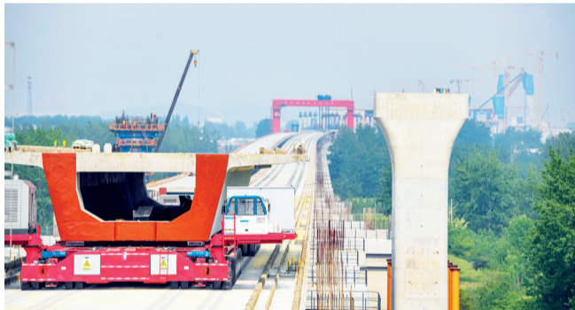
运梁车将千吨箱梁从提梁点运送至架桥作业点
