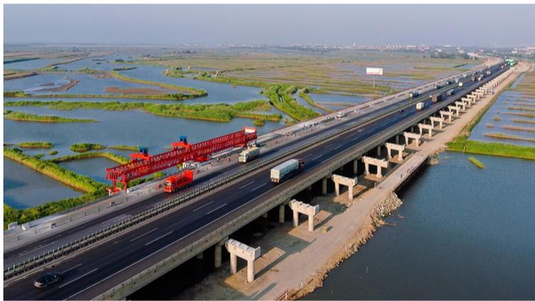
6月17日,中铁四局五公司承建的(北)京哈(尔滨)高速公路改扩建工程绥中至盘锦段9标北京侧中小桥架梁全部完成。京哈高速公路改扩建工程绥中至盘锦段是国内首条百公里级、超多车道、超大重载交通量的高速公路改扩建工程,全长约222.08公里。其中,五公司承建的9标管段长27.78公里,施工内容包括特大桥1座、大桥2座、中桥15座、小桥24座、通道桥12座,具有跨国家湿地保护区范围广、征拆协调难度大、交通疏解规模大的特点。
