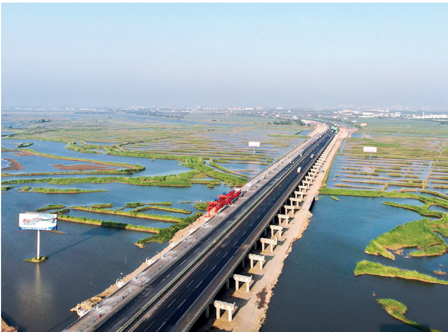
绕阳河特大桥架梁
