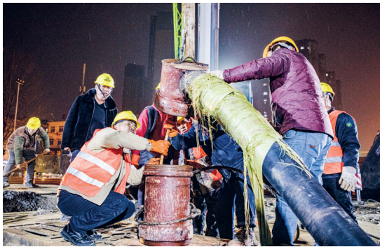
青龙桥3.5米超大直径桩基浇筑完成
