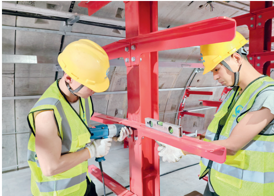
区间上仓工艺支架安装
