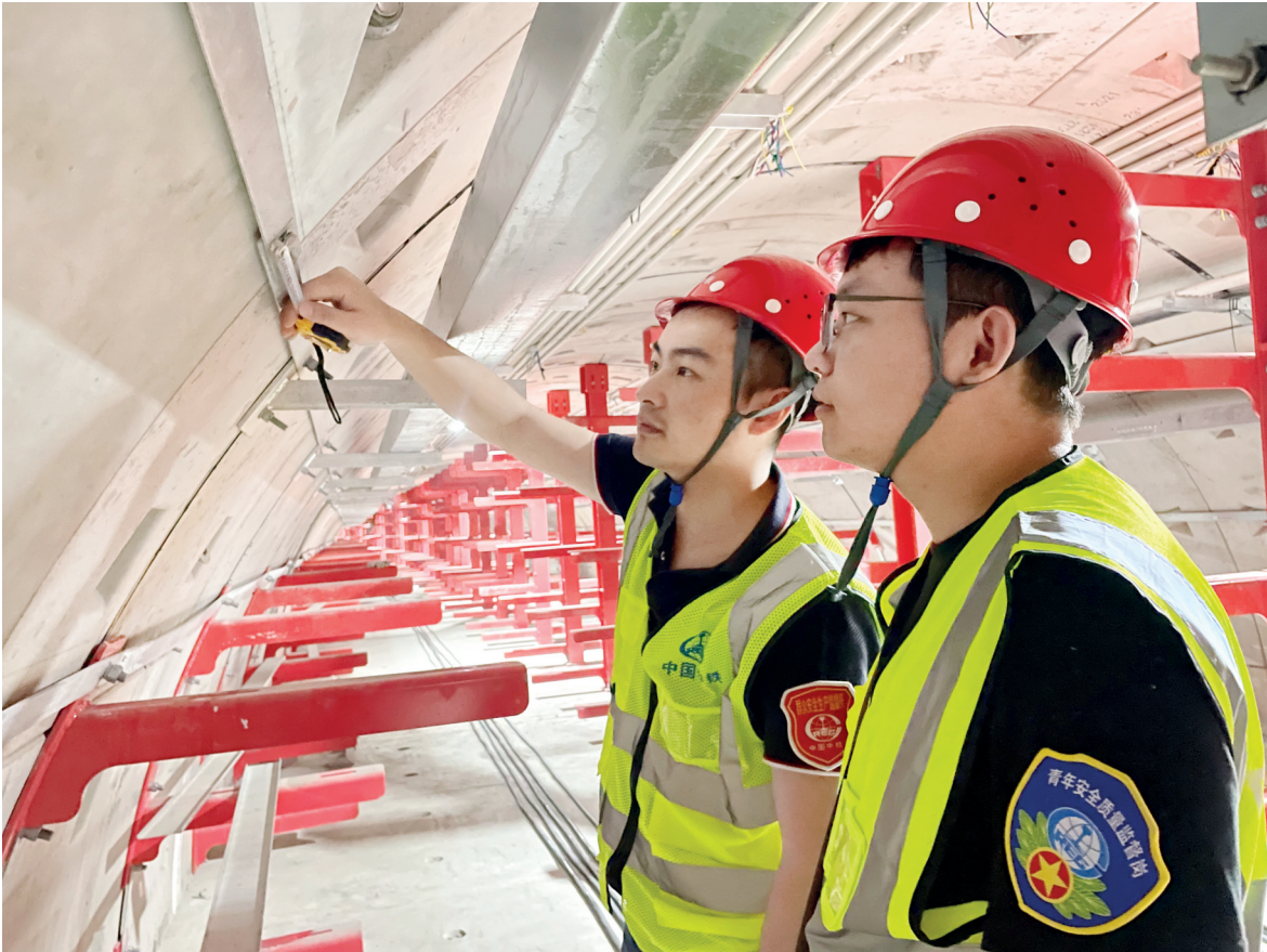
检查接地扁钢搭接长度
