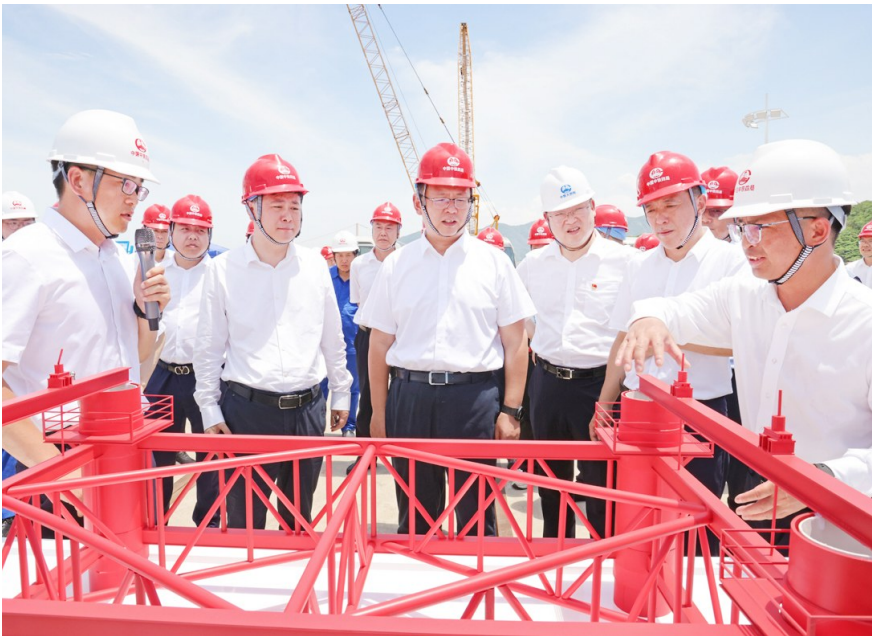
陈文健(中)听取项目部关于深水裸岩钢栈桥板壳法施工汇报 弋鹏丽 摄
