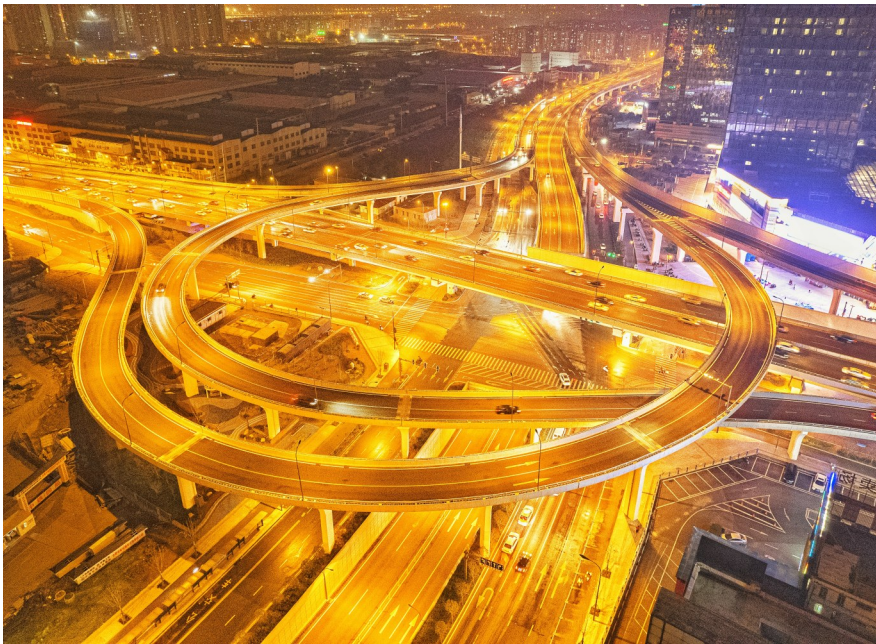
合肥市宿松路快速化改造工程全线通车 菊轩摄
