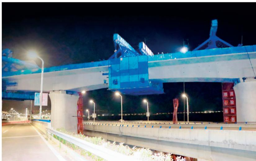
7月16日凌晨,历经5小时连续奋战,由中铁四局承建的渝昆高铁跨沪昆铁路和哨关大道连续梁首个合龙段浇筑完成。此次合龙段施工为渝昆高铁云贵段首个悬臂施工连续梁跨合龙。该连续梁位于昆明市官渡区小哨街道八家村,全长196米,采用(45+68+42+41)米不等跨连续梁上跨沪昆铁路和哨关大道。不等跨连续梁具有受力复杂、体系转换多、上跨城市快速路安全风险高等特点。
