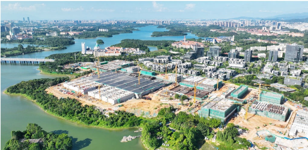
松山湖水厂一期工程施工鸟瞰
