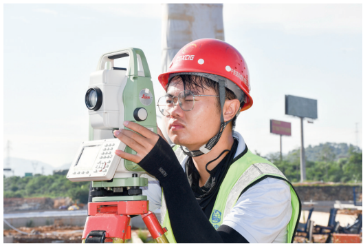
七分公司崇凭铁路1标项目部技术员正在进行测量 吴寅 摄(影像四局)
