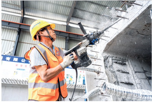
五公司湛江机场高速公路梁场工人正在进行凿模作业 沈嘉鹏 摄(影像四局)
