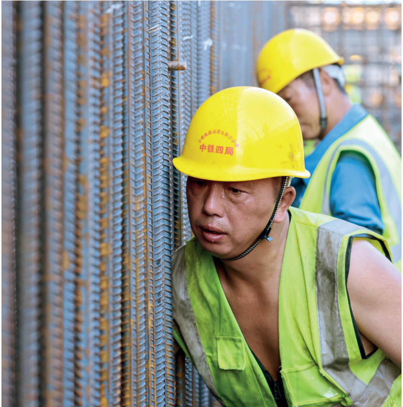
四公司合新铁路安徽段7标项目部工人调整现浇梁预埋钢筋位置 苏诗洋 摄(影像四局)
