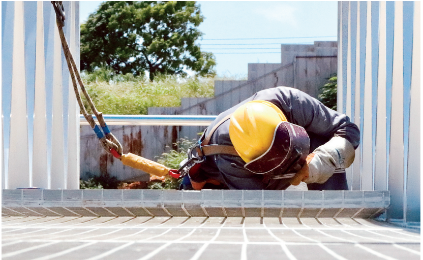
三公司福州江阴污水处理厂项目部工人正在安装设备 李煜 摄(影像四局)
