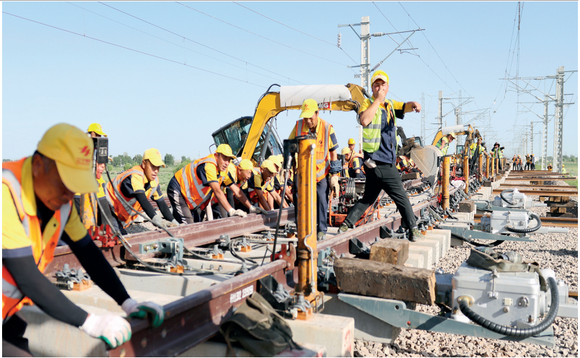
六公司鄂尔多斯华茂铁路专用线项目部道岔铺设 李向东 摄(影像四局)
