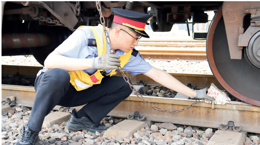
八分公司朔黄分处西柏坡站助理值班员对站内停留列车采取铁鞋防溜措施 付俊 摄(影像四局)
