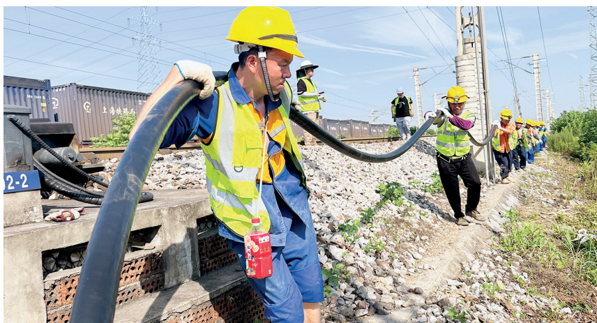
电气化公司合安铁路引入合肥枢纽站后四电接触网供电电线电缆顺利敷设完成 潘星 摄(影像四局)
