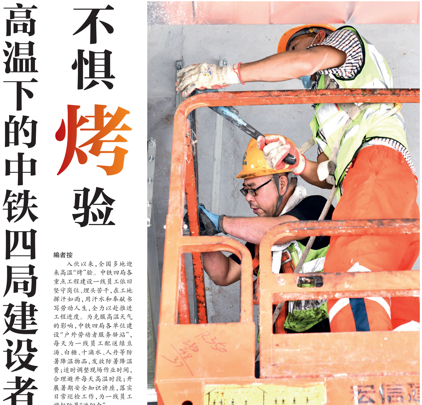
六公司西咸环隧项目部工人正在进行装饰装修施工 雷智宏 摄(影像四局)
