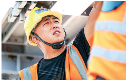
一公司合肥清澜苑项目部工人在安装铝模 倪明 摄(影像四局)
