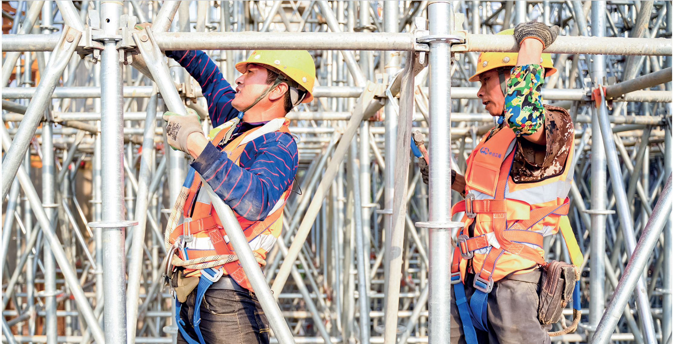
五公司南昌西二环连接线(赣新大道)项目部工人正在搭设脚手架 刘佳星 摄(影像四局)
