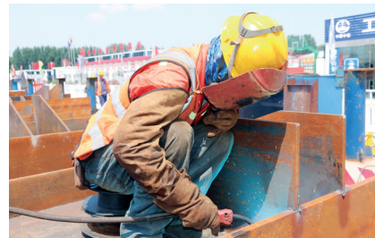
钢结构建筑公司雄商高铁11标项目部工人正在焊接作业 张志华 摄(影像四局)
