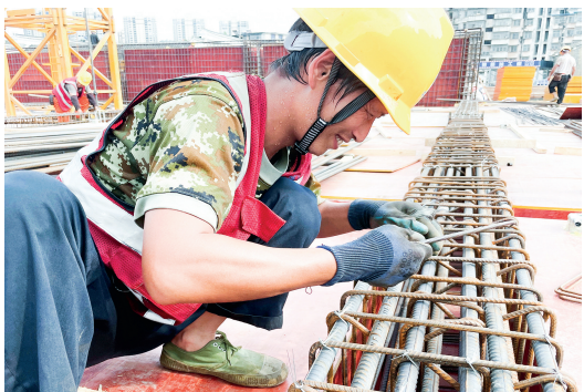
安装公司修水县老城祠堂遗址文恭设施项目部工人进行主体结构钢筋绑扎 武海康 摄(影像四局)
