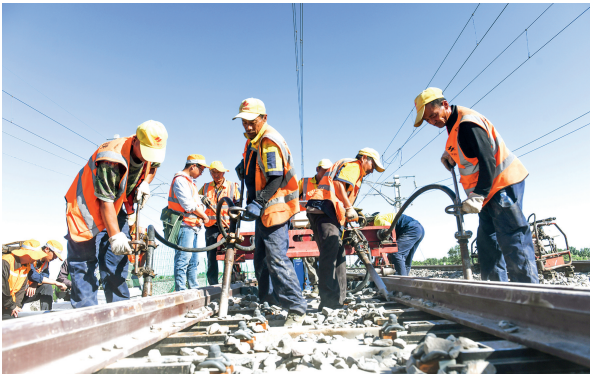
振捣作业施工
