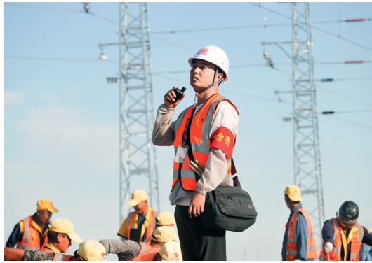
安全员指挥现场施工
