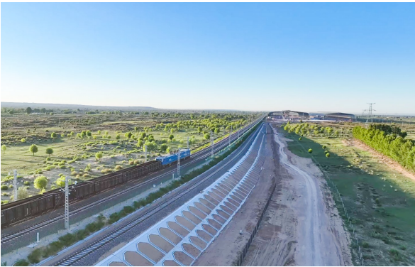
插铺完成后首列火车安全顺利通过
