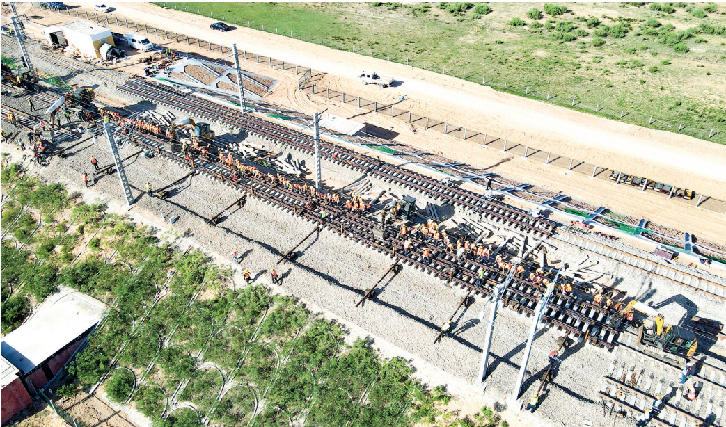
道岔插铺施工现场航拍
