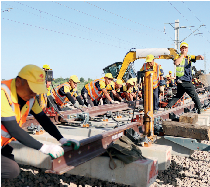
道岔横移作业
