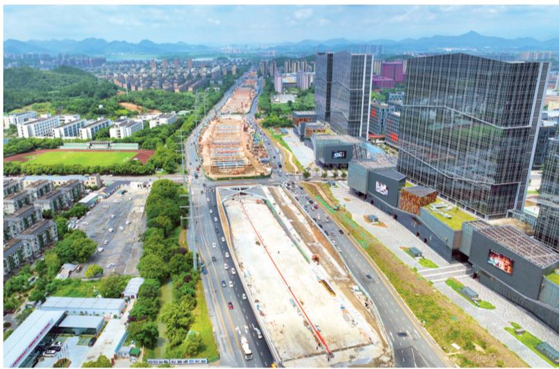
7月21日,中铁四局三公司承建的杭州市文一西路西延一期工程智溢路至数云路段主体隧道结构验收。该工程长1.855公里,由快速路系统和地面主干路系统组成,设计为“双向6车道+双向8车道”,全线采用明挖法施工。项目建成后,可与文一路隧道、德胜快速路连接,串联未来科技城与杭州市主城区,提高路网通行效率。
