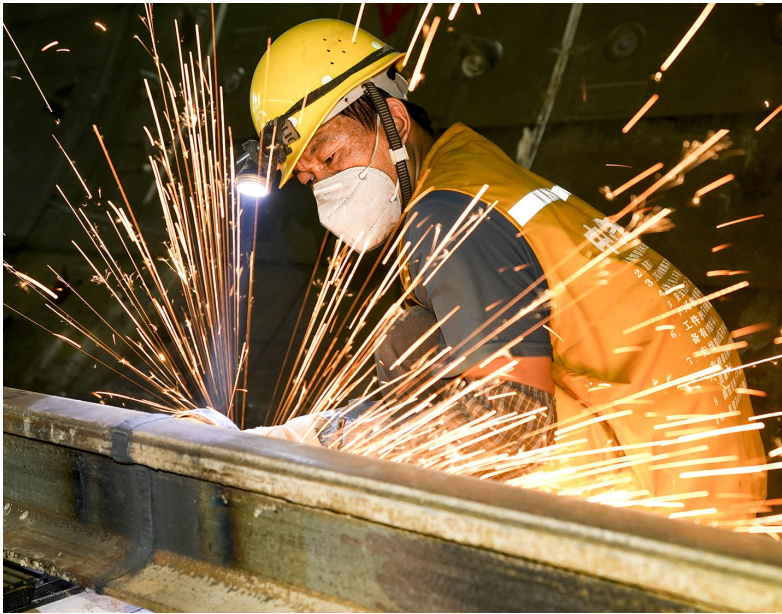
钢轨焊头粗磨作业
