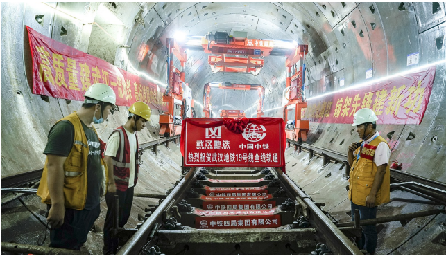
全线最后一排轨铺设到位
