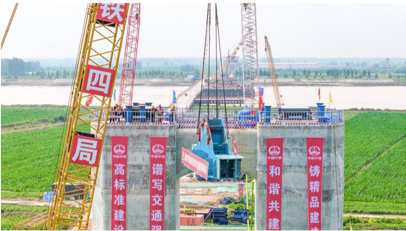
7月31日,随着一段长9.73米、宽3.24米、高3.86米、重66吨的钢桁梁精准吊装就位,由中铁四局承建的雄商高铁黄河特大桥主桥正式进入钢梁架设阶段。
