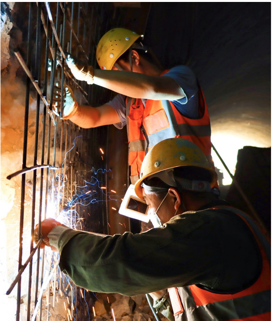
安装二台阶钢筋网片 张书朋 摄(影像四局)
