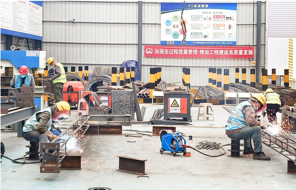
青岛地铁5号线钢筋加工厂 张书朋 摄(影像四局)
