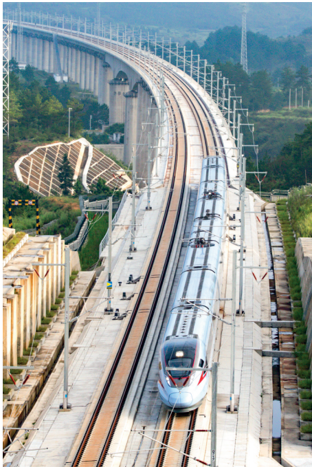
贵南高铁贵阳至荔波段首发列车通过拉里双线特大桥
