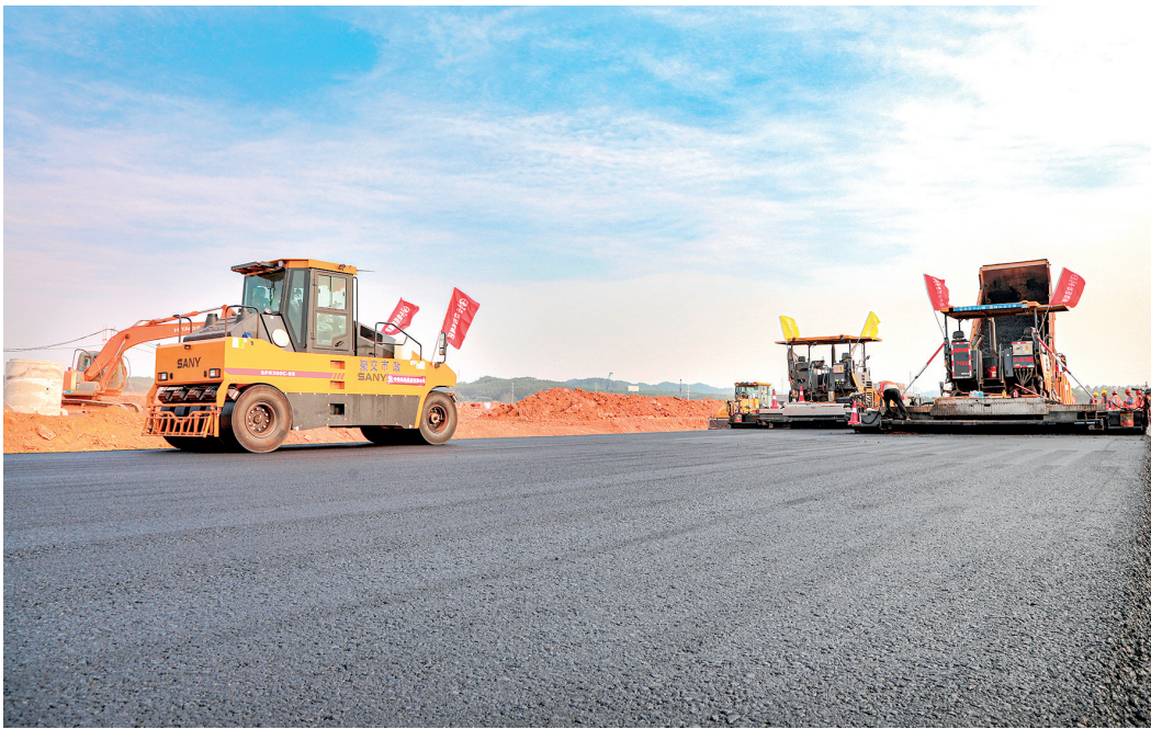
沥青摊铺施工 冯韶洋 摄(影像四局)
