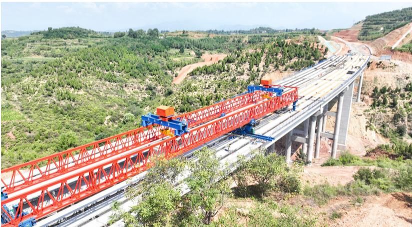
8月13日,随着最后一块长40米、重达140吨的预制T梁缓缓落下,由中铁四局一公司承建的济源至新安高速公路大岭大桥架梁施工全部完成。大岭大桥位于济新高速济源段,全长248米,桥墩采用双柱式墩和薄壁空心墩,上部搭建6×40米混凝土预应力混凝土T梁。大岭大桥所在区地势陡峭,施工过程中,大型机械难以进入,桩基全部采用人工挖孔,施工难度风险极大。
