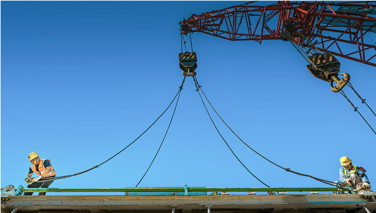
盾构机台车吊装
