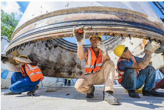
工人对盾构机进行盾尾密封、螺栓调节
