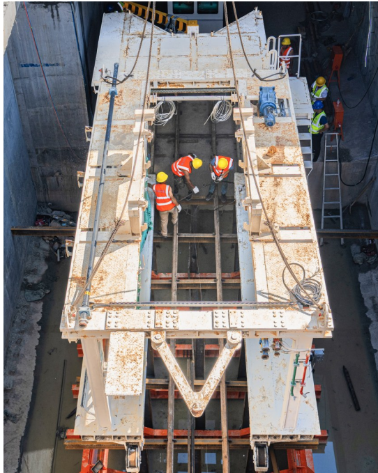
盾构机台车下井
