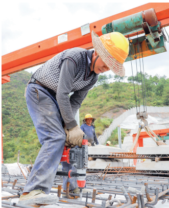
基长一号隧道与二号隧道之间无昨轨道施工 马奎宏 摄(影像四局)
