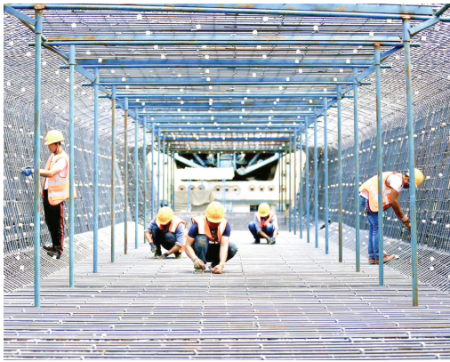
预制箱梁绑扎钢筋 马奎宏 摄(影像四局)
