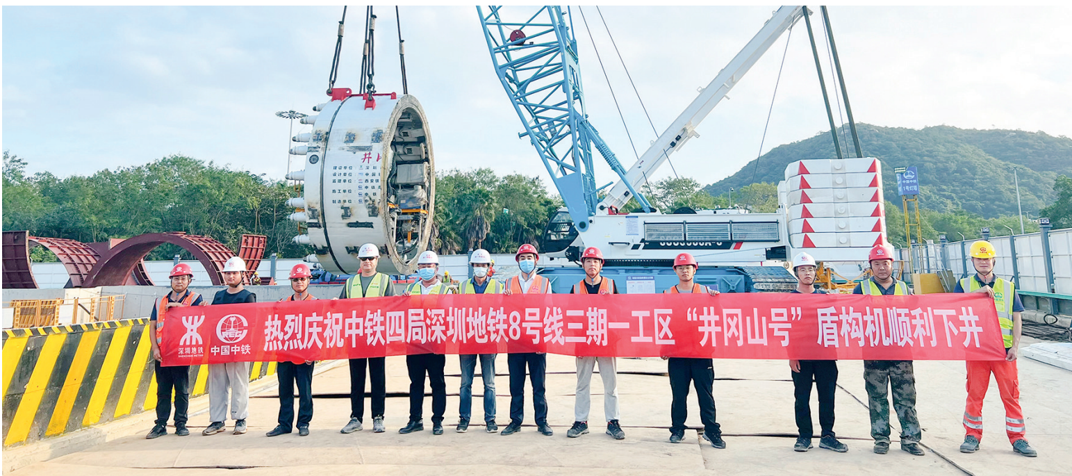
深圳地铁8号线三期首台盾构机顺利下井组照 夏紫璇 摄(影像四局)
