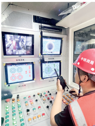
盾构操作手正在汇报盾构机的实时数据 屈伟光 摄(影像四局)
