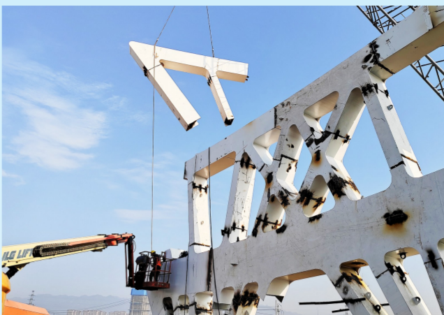
西桥最后一件钢桁梁吊装 林旺 摄(影像四局)
