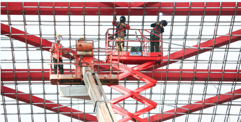
东桥顶部焊接施工 覃仁财 摄(影像四局)
