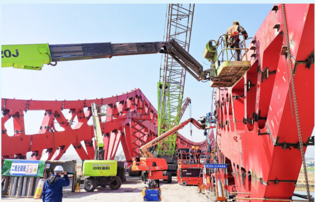
东桥施工现场 林旺 摄(影像四局)
