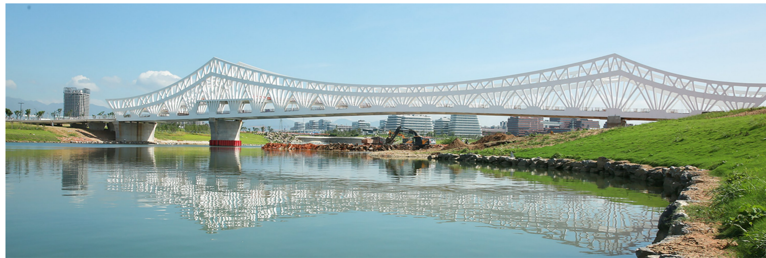
西桥主体施工进入尾声 覃仁财 摄(影像四局)
