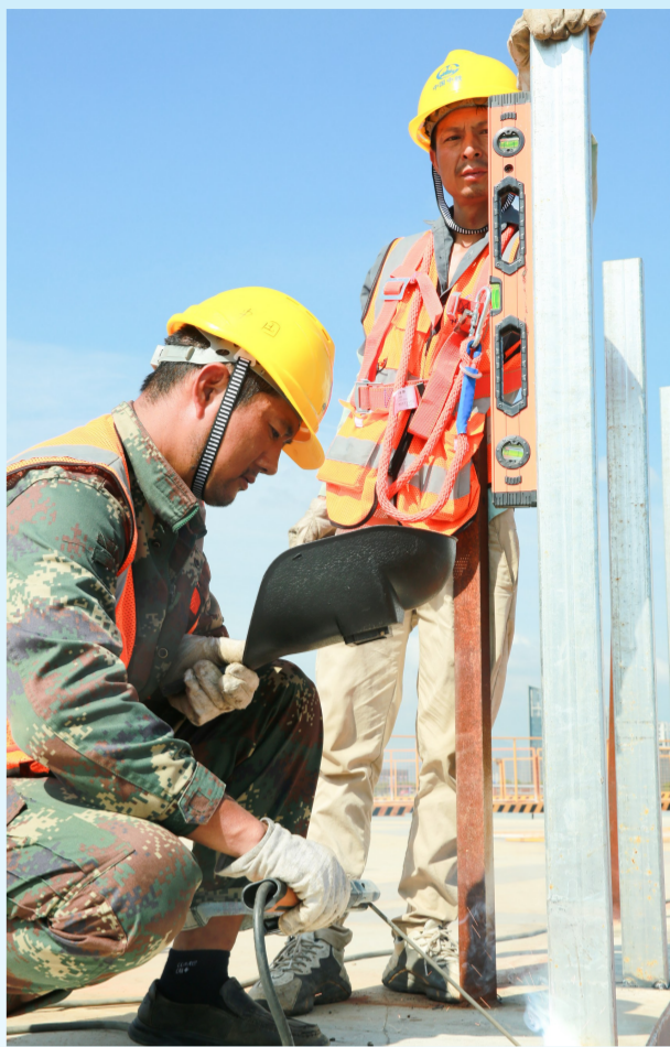
郑为祥和工友进行西桥桥面附属焊接施工 覃仁财 摄(影像四局)
