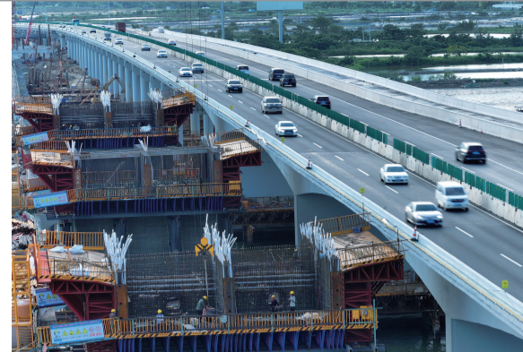
已开通的右幅道路川流不息,左幅桥梁建设正酣。
