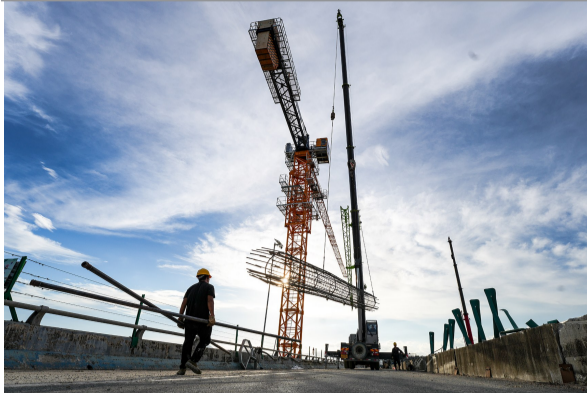
工人正在进行钢筋笼吊装作业。
