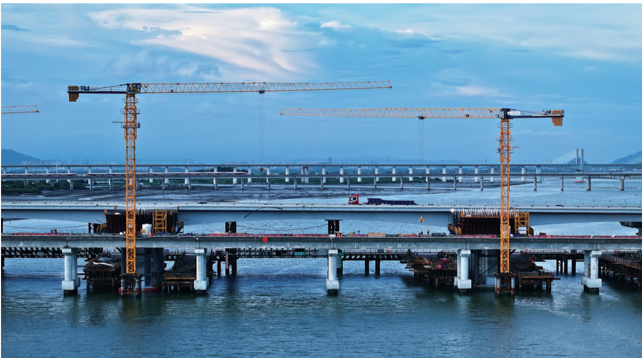
深(圳)汕(尾)西高速改扩建项目长沙湾跨海特大桥。
