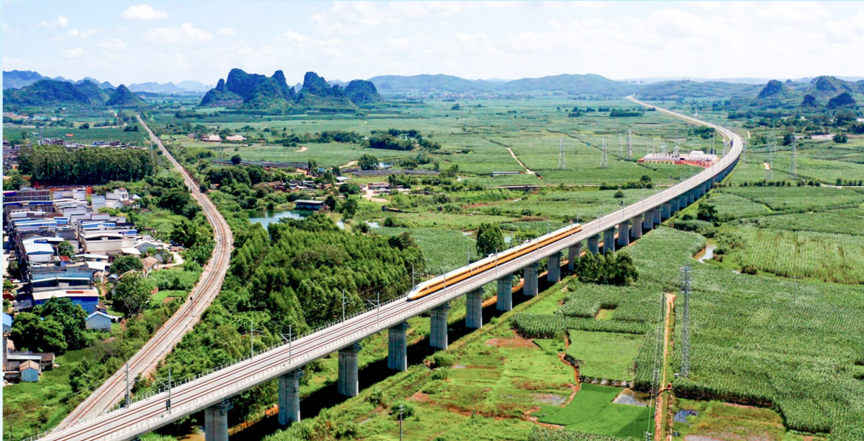
南崇铁路4标开通运营 王辉 摄(影像四局)
