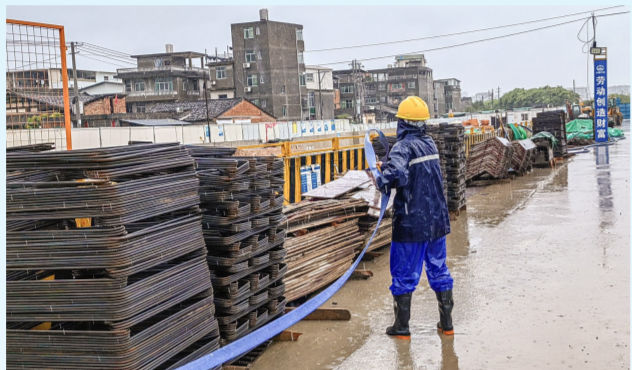
7月28日,城轨分公司福州滨海快线项目部要求值班人员每隔4小时巡视各站点出入口积水情况。紧急停止所有工程作业,在各出入口预装防淹挡板和水泵,除抽水、照明、视频监控、盾构外,切断其他一切施工用电。组织人员撤离,布置应急避难安置点,准备生活必需品,切实保障参建人员的生命财产安全。 丁钰
