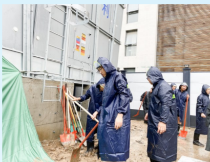
7月29日,三公司北京通州台湖图书城提升改造项目部组织“党员突击队”堆放防汛沙袋,每隔4小时对B库东侧的排水沟、管理用房、积水情况进行安全巡查,并协助建设单位北京城市副中心投资建设集团有限公司做好应急抢险工作。 赵一薇 马航
