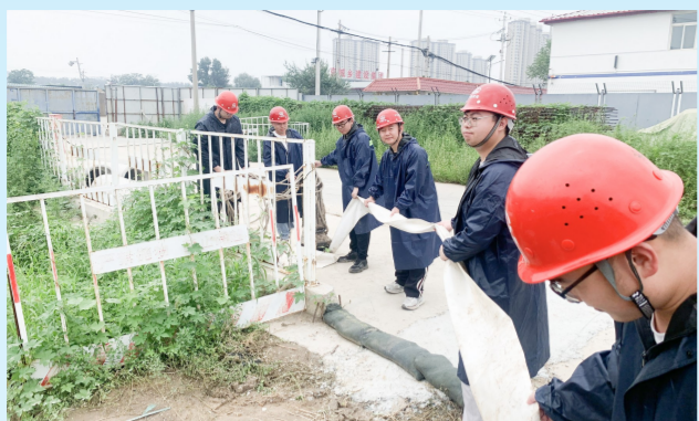
7月28日,三公司北京城市副中心区域项目部迅速制定《防汛值班表》,筹措沙袋、抽水机等防汛物资,布置在行政办公区综合管廊10标、春明西路综合管廊、西滨河路道路、畅和西路管廊及道路6标的基坑和结构预留孔洞周围。 刘默涵 付子新
