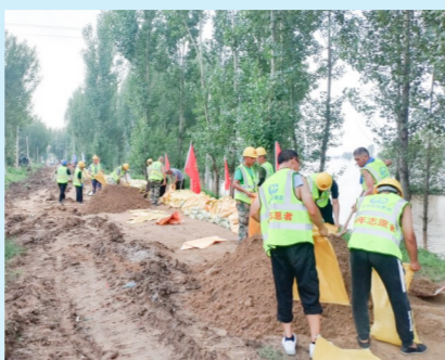
7月29日,四公司合肥轨道交通6号线项目部对搅拌站、钢筋棚、板房、大型门吊、架桥机等再进行加固,对应急库房内的水泵、铁锹等物资进行核查,安排专人实时播报天气动态。 朱迦南
