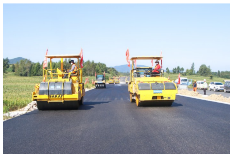
沥青中面层试验段摊铺后进行碾压 王野摄(影像四局)
