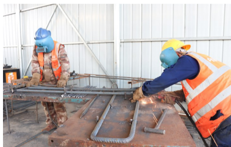
人们对螺纹钢进行焊接 王野摄(影像四局)
