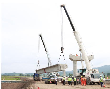
承德立交桥首根箱梁架设 王野摄(影像四局)
