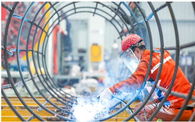
钢筋笼加工 谭彬 摄(影像四局)
