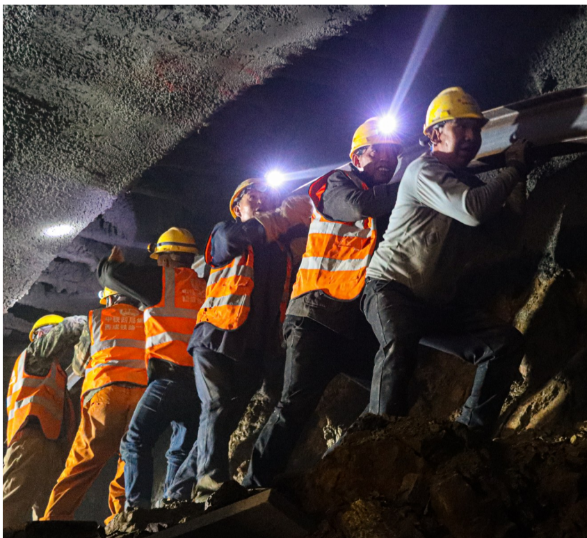
工人正在进行隧道钢拱架安装 刘陈永 摄(影像四局)
