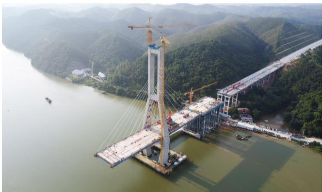
9月8日,中铁四局钢结构建筑公司承建的上(林)横(县)高速公路西津郁江特大桥南岸边跨合龙。至此,西津郁江特大桥南、北两岸边跨全部合龙。西津郁江特大桥全长1190米,主桥长680米,主跨400米,为双塔双索面钢混组合梁斜拉桥。
