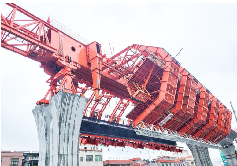
9月7日,中铁四局城轨分公司佛山轨道交通4号线4203标项目部2号移动模架完成首次过孔作业,标志着东莲高架区间26孔简支梁浇筑连续性施工开始。佛山轨道交通4号线一期工程全长55.22公里,4302标承担3站5区间共5.67公里施工任务,其中,高架区间段共设置三台移动模架,进行107孔简支箱梁的施工作业。此次过孔作业为项目首次平纵曲线结合,大坡度过孔,作业难度大。
