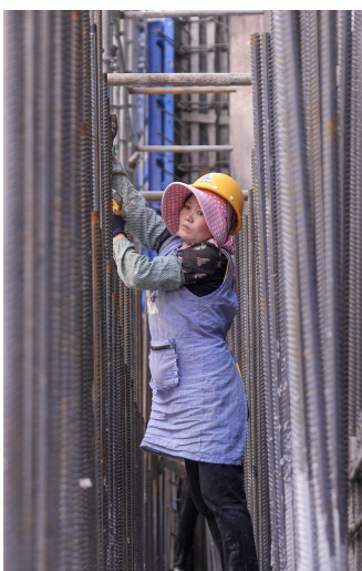
侧墙钢筋绑扎 李海涛 摄(影像四局)
