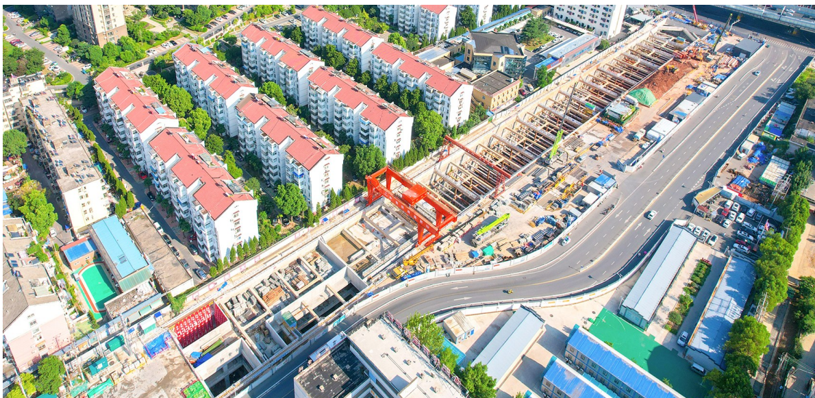
合肥新桥机场S1线先行段五里墩站现场航拍 郎成涛 摄(影像四局)
