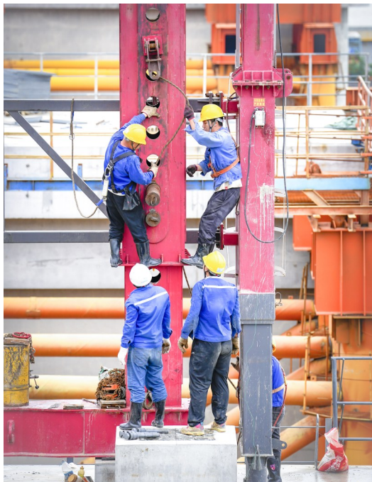
架梁准备阶段,作业人员紧固JQBS1100型架桥机前支腿
