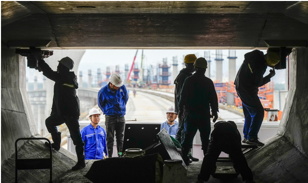
作业人员紧固箱梁螺栓
