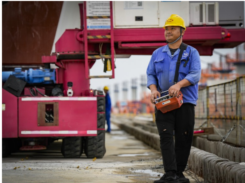
作业人员操控运梁车运梁
