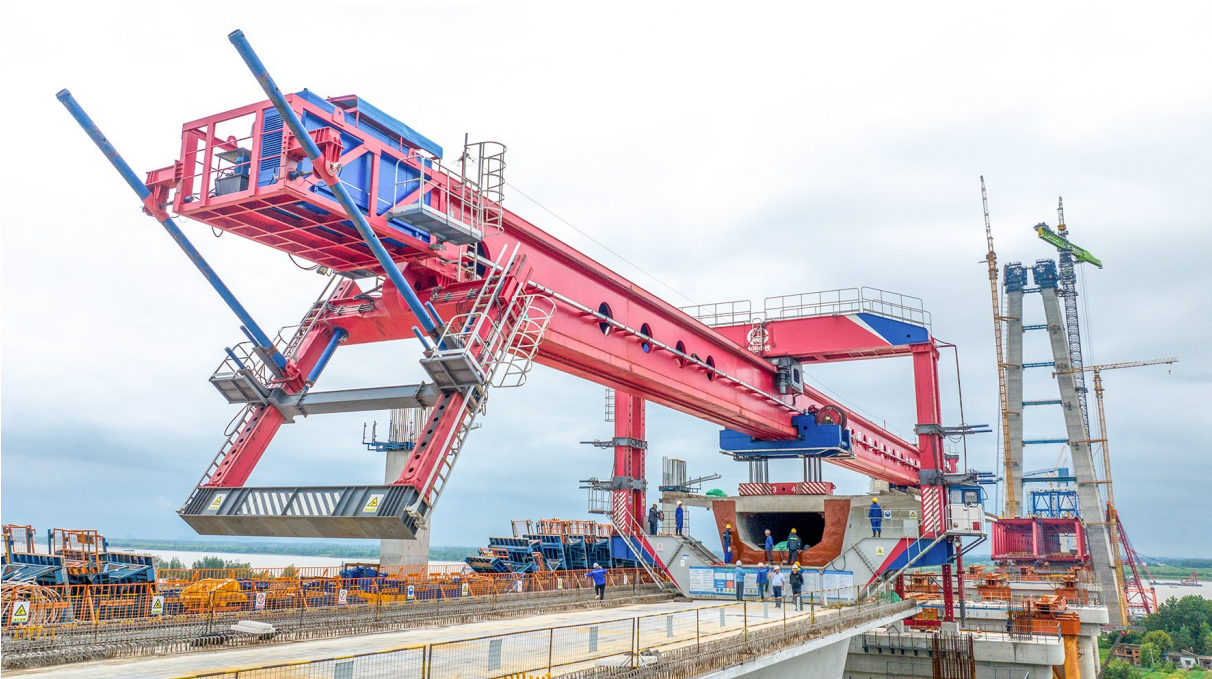
架桥机开始落梁作业
