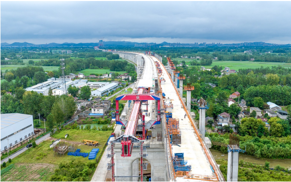
巢马城际铁路马鞍山长江公铁大桥施工现场
