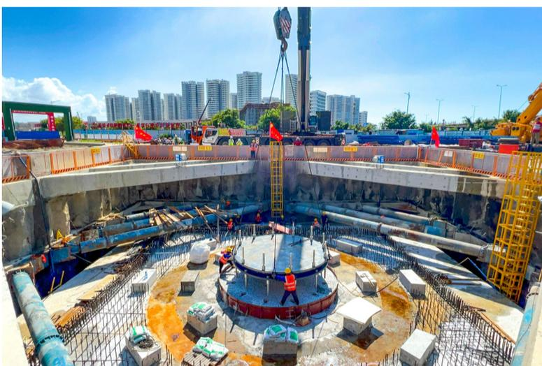
9月22日，经过施工人员近20个小时的连续作业，中铁四局一公司承建的海南省在建最大跨度跨铁路单幅转体桥暨海口新海港片区“二线口岸”涉铁项目转体桥支座安装完成，标志着转体桥进入转体系统施工阶段。
