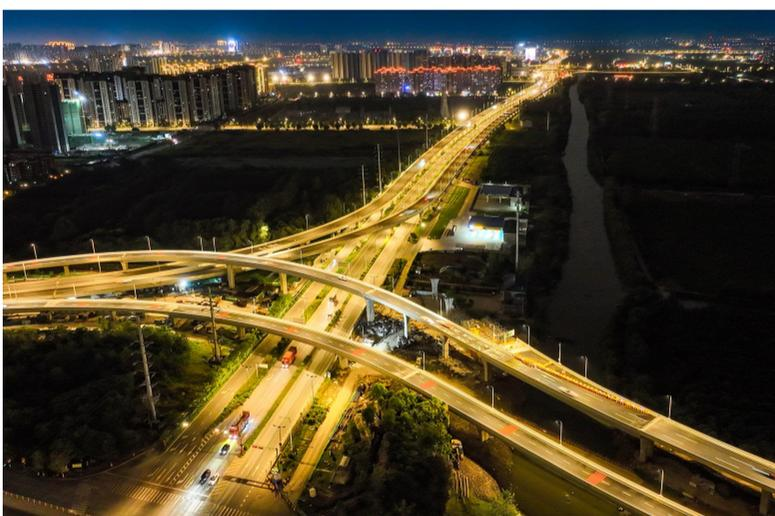
9月23日20时08分，随着首批社会车辆驶入盐城市青年路高架西延工程主线，由中铁四局二公司承建的青年路高架西延工程正式建成通车。青年路高架西延工程全长2.44公里，双向四车道，设计时速80公里。二公司承建的青年路西延工程包含主线桥1座、上下匝道2座、互通匝道3座、拼宽桥3座、地面辅路改造1条。
