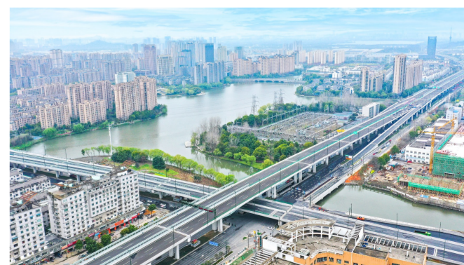
绍兴329智慧快速路
