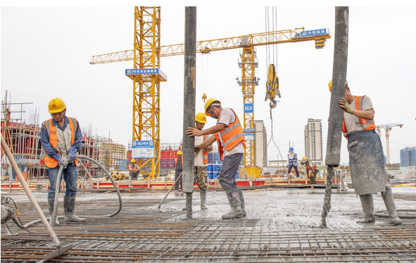
浇筑混凝土
