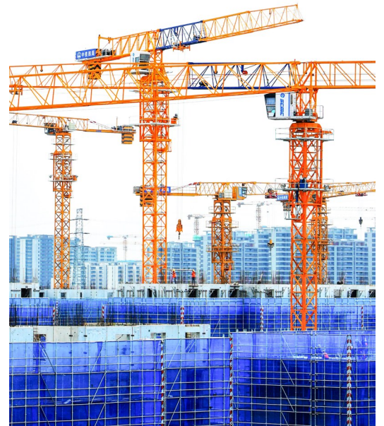
塔吊吊装作业
