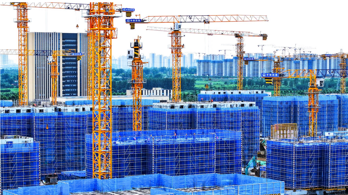
楼层主体作业
