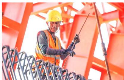
调整梁侧部钢筋顶端
