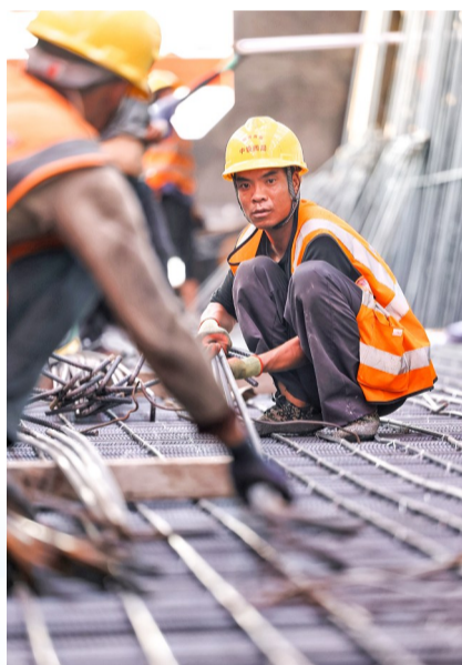
绑扎梁底板钢筋
