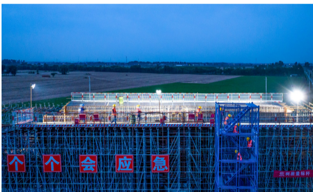
蒙城特大桥上跨蔬菜大道连续梁施工
