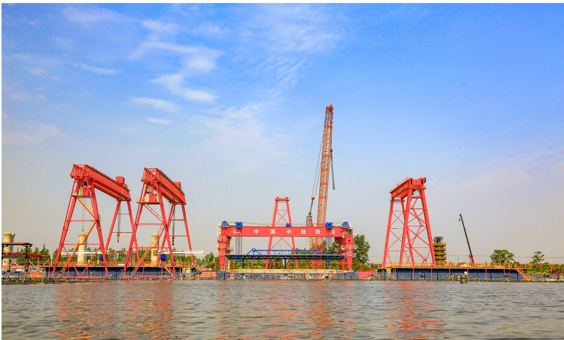
祝慧制梁场全景
