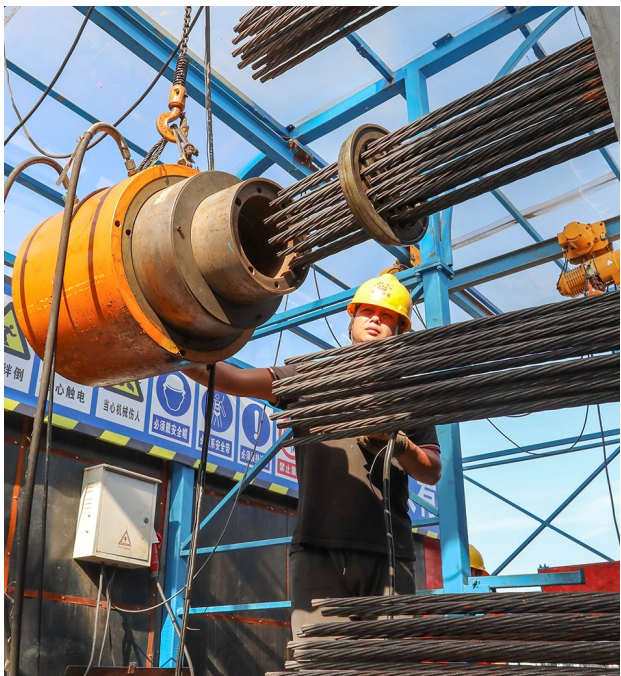
预制箱梁张拉作业
