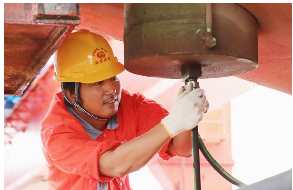
工人调试作业准备
