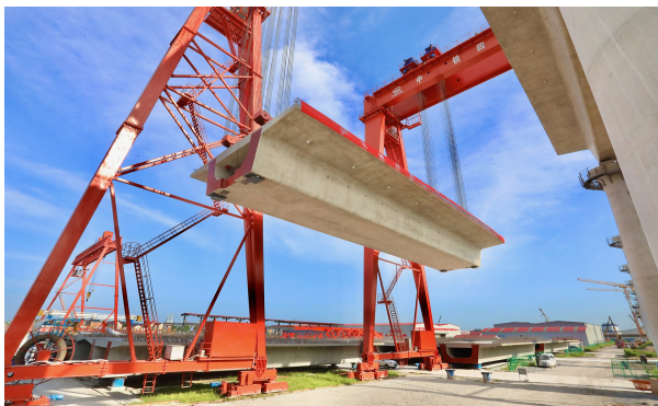
梁场提梁作业
