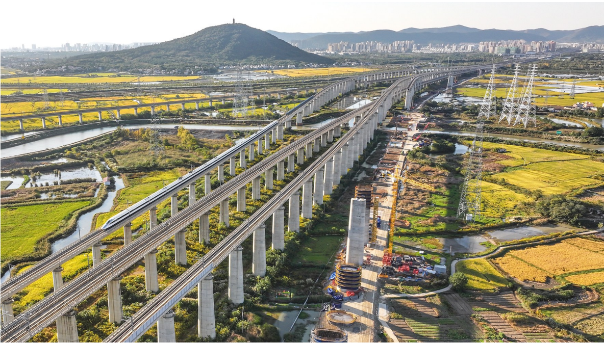
建设中的清溪河特大桥
