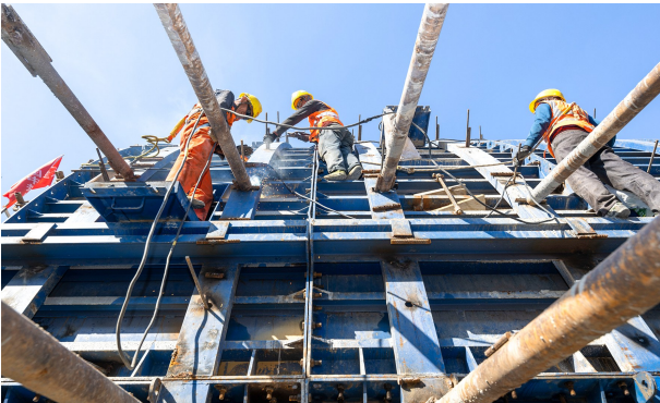
含山隧道明洞正在进行二次衬砌施工
