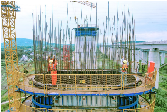
巢马铁路临近营业线施工
