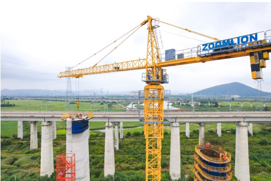
巢马铁路高墩施工
