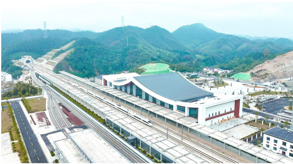
试运行列车经过祁门南站 来源:中国铁路
