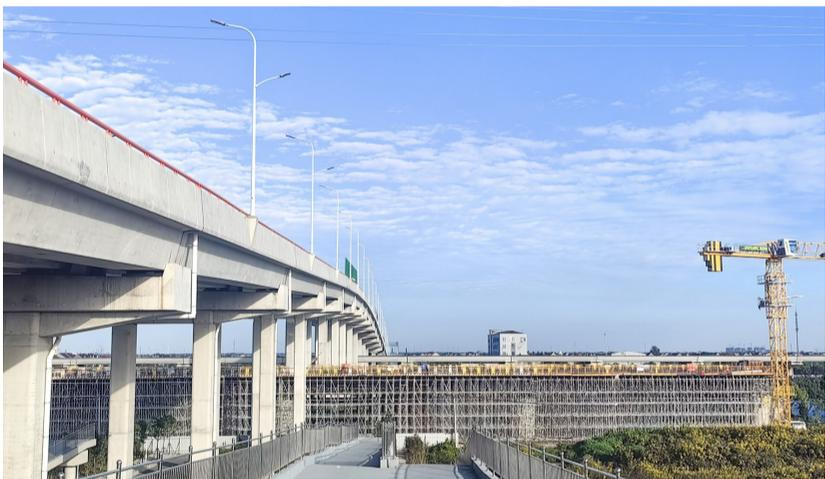
10月28日,中铁四局二公司承建的沪(上海)(南)通铁路站前VII标首座道岔连续梁合龙。该标段共设计两座道岔连续梁,本次合龙的道岔连续梁穿越黄公路,梁长163.3米,采用桥位处分阶段支架现浇施工。 赵世博 摄(影像四局)
